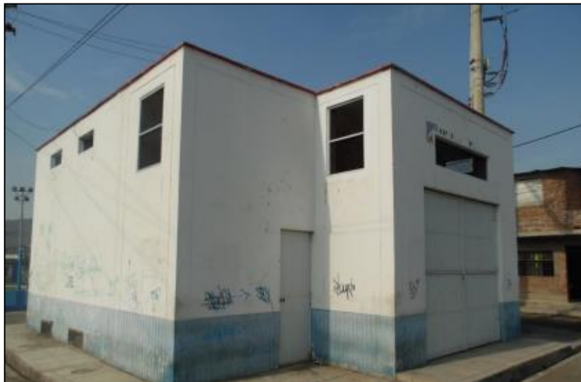
Figura 1. Instalaciones de la SE SALAVERRY
